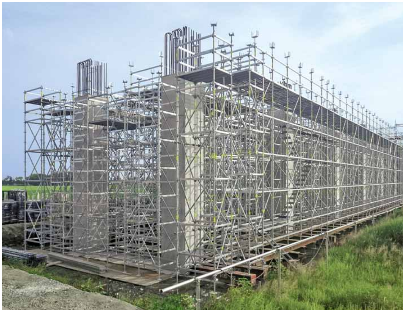
北海道新幹線建設工事
