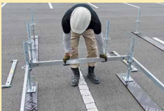
3) ベース支柱のロゼットプレートに水平材のクサビを差し込み支柱同士をつなぐ
