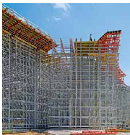
橋梁工事 (スロバキア共和国)
