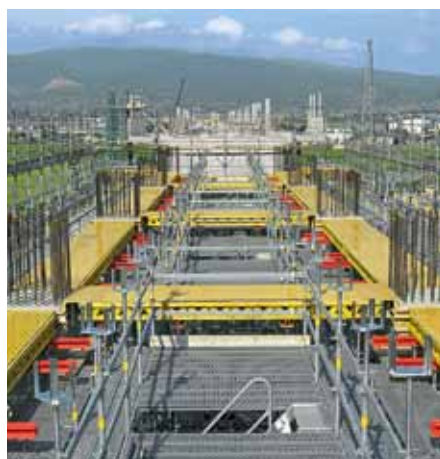
梁下型枠設置
