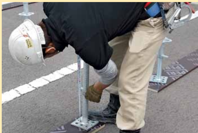
1) 墨出し後、ベーススピンドルの長さを調整し、敷板に配置する
