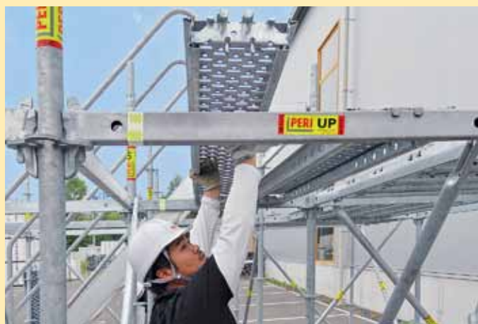
10) 鋼製足場板UDGを敷き、階段を取り付ける 1層目と同様の手順で最上段まで組み立てる
