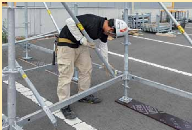
8) 四角塔の4側面の水平材にブレースUBLを 取り付ける
