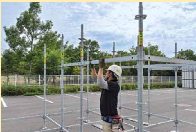
7) 支柱3段目のロゼットプレートに 水平材のクサビを差し込み支柱同士をつなぐ
