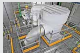
プラント足場
