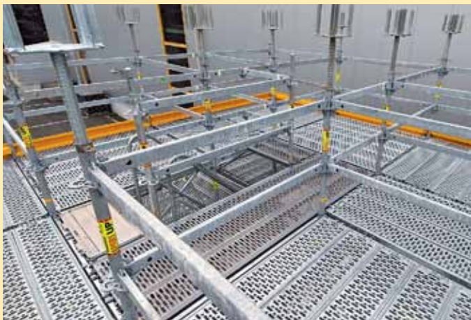
11) トップ支柱UVHの間に鋼製巾木UPYを設置するクロスヘッド スピンドルを支柱に差し込み、スピンドルの長さを調整する
