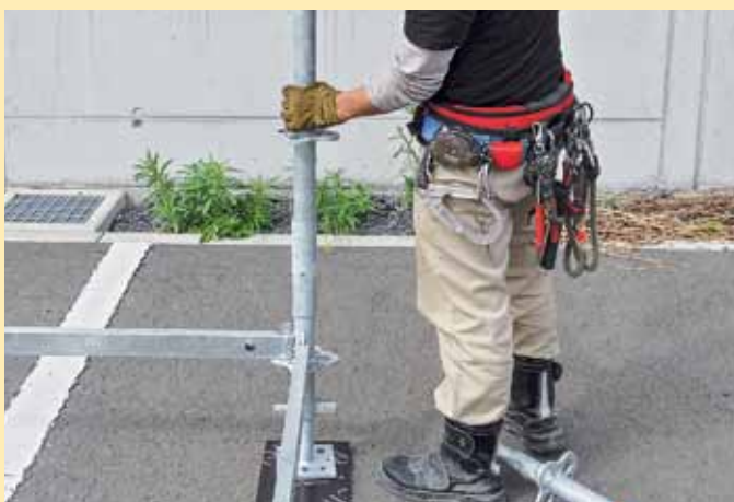
6) ベース支柱UVR24に支柱UVRを差し込む
