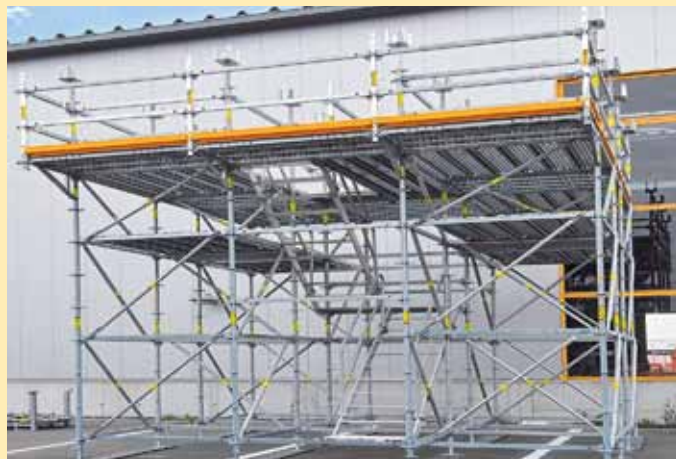
12) 大引き材を設置し、完成
