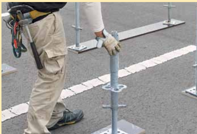
2) ベース支柱UBV24をベーススピンドルに差し込む
