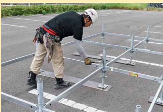
4) 水平材のクサビをハンマーで2~3回かきしめる
