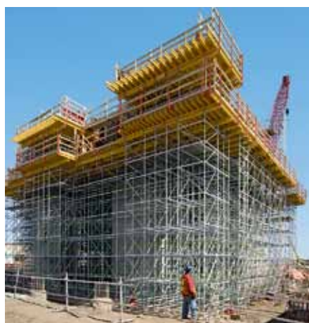
産業構造物工事 (カナダ)
