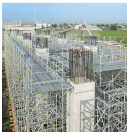
隙間のない作業床
