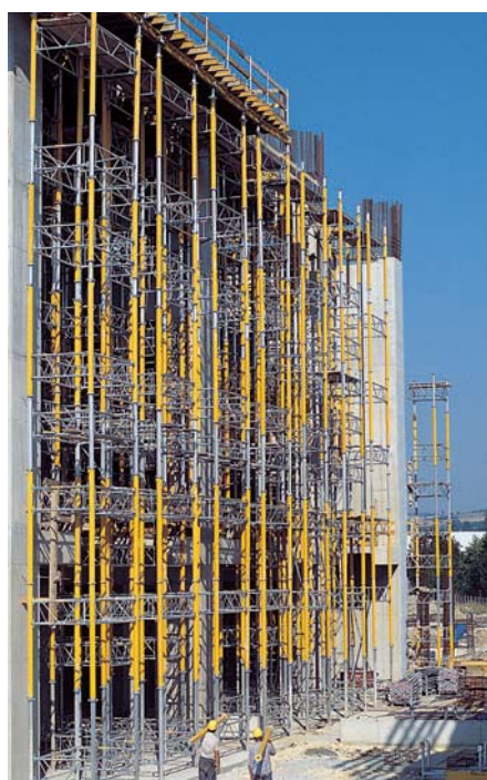
キャンチレバースラブ を支える高さ20mの マルチプロップタワー
