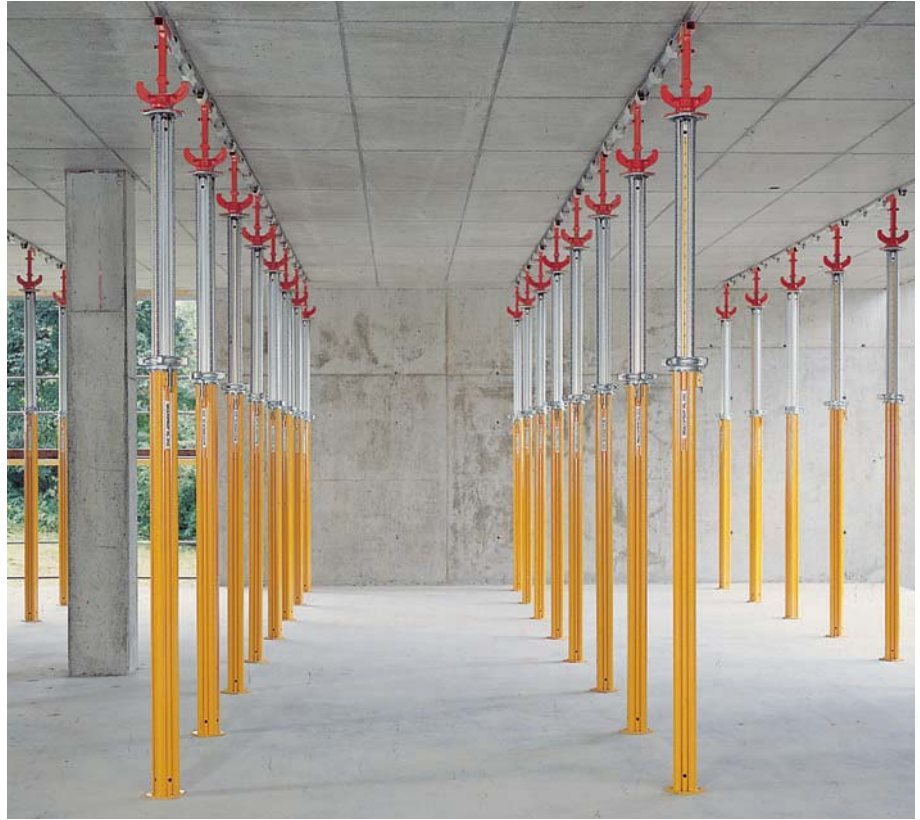
脱型後のマルチプロップMP350、スライデックスラブ型枠
