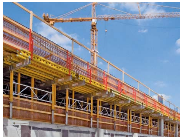
マルチプロップタワー メインビームとしてMPBアルミビームを、クロスビームとしてPERIトラスビームGT24を使用
