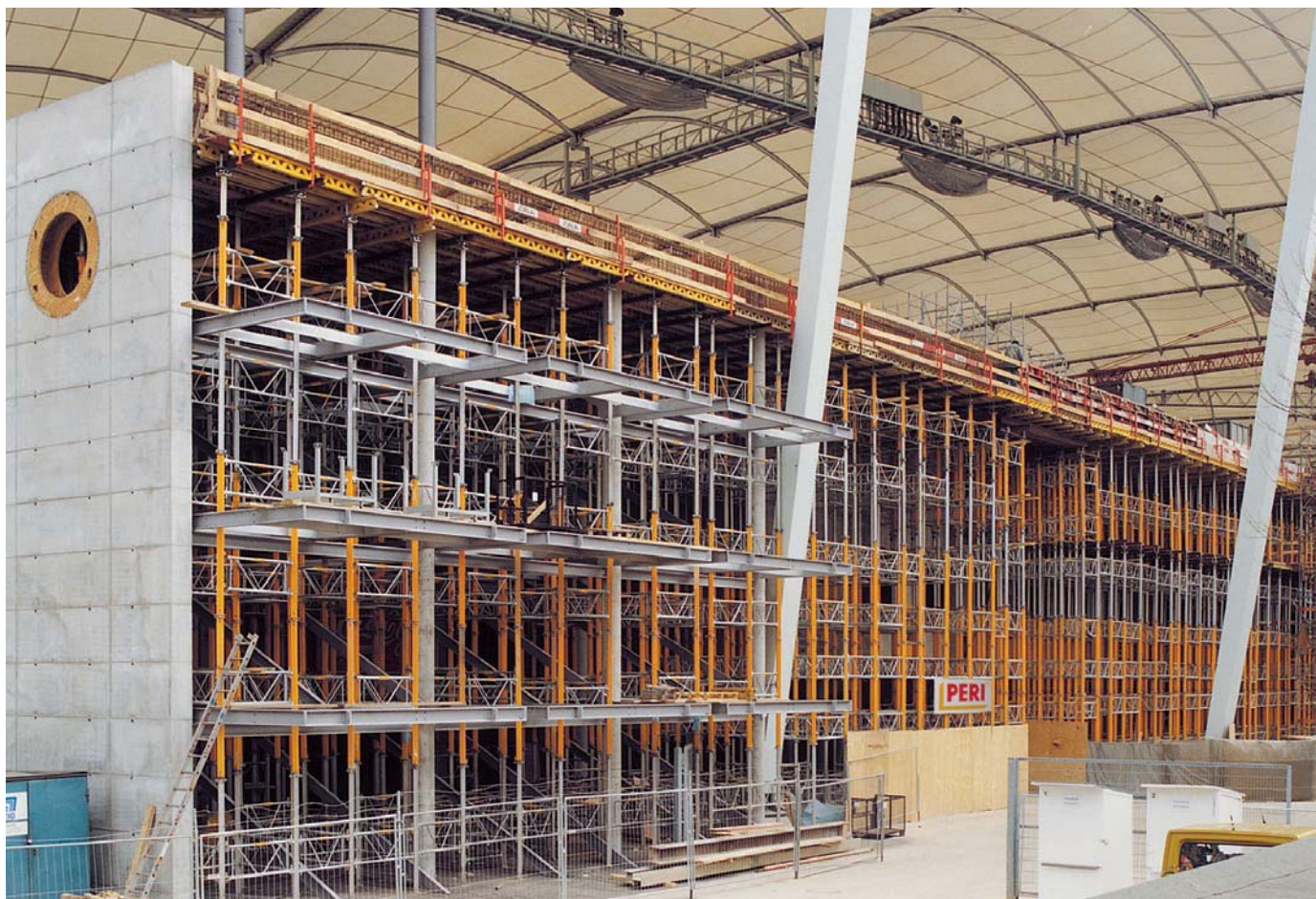
高さ14mのマルチプロップ支保工 (面積：3,500㎡)
