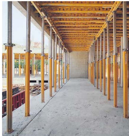
マルチプロップ350と マルチフレックス スラブ型枠
