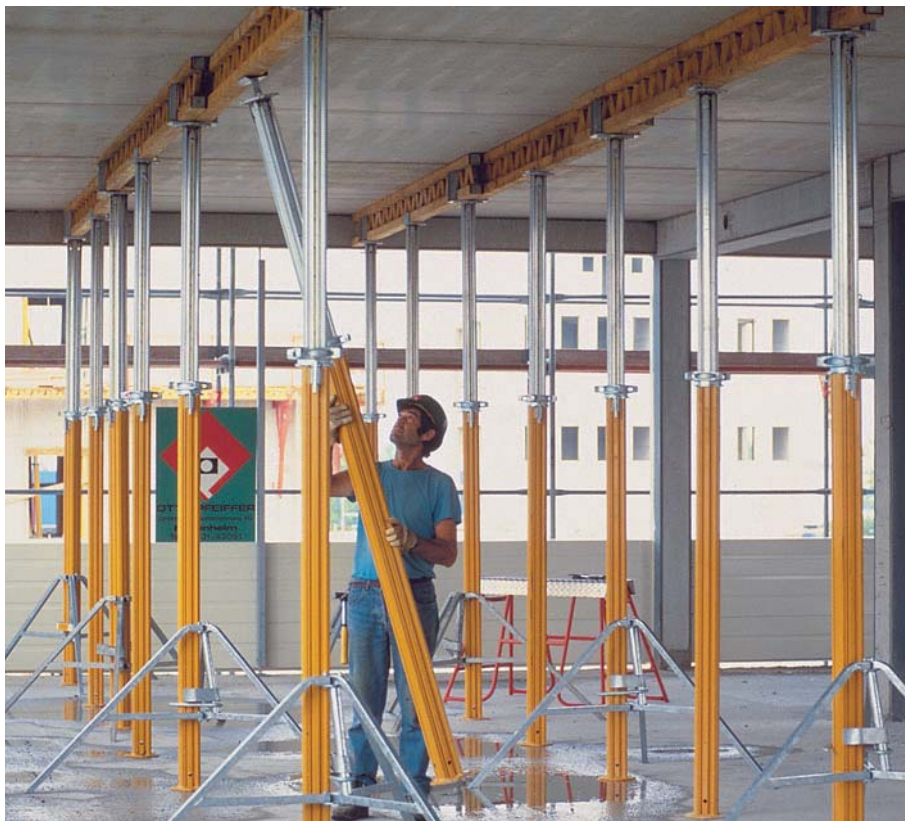
作業員1名で簡単に安全に作業ができます
