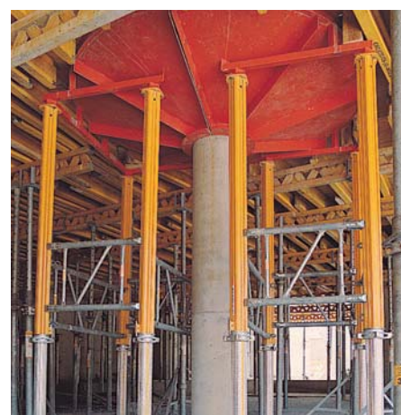
柱型枠を支える マルチプロップMP350
